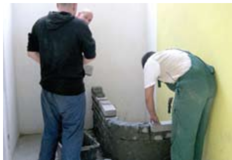
Prace budowlane w faziencie
