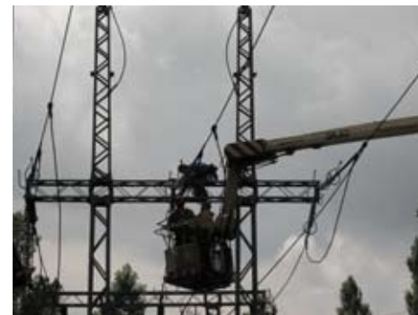
Wymiana izolatorów na linii 110 KV
