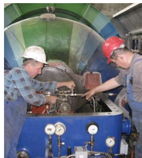
Przebieg prac remontowych w bloku przednim turbiny 13UCK80
