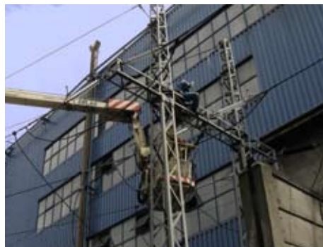
Wymiana izolatorów na linii 110 KV
