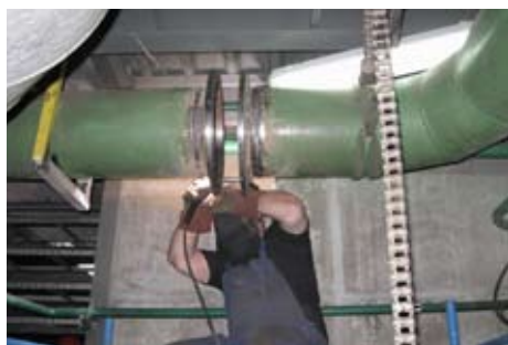
Montaż przepustnicy regulacyjnej na rurociągu wody sieciowej w maszynowni
