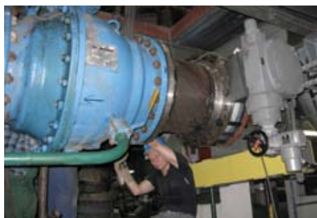
Montaż przepustnicy regulacyjnej na rurociągu wody chłodzącej w maszynowni
